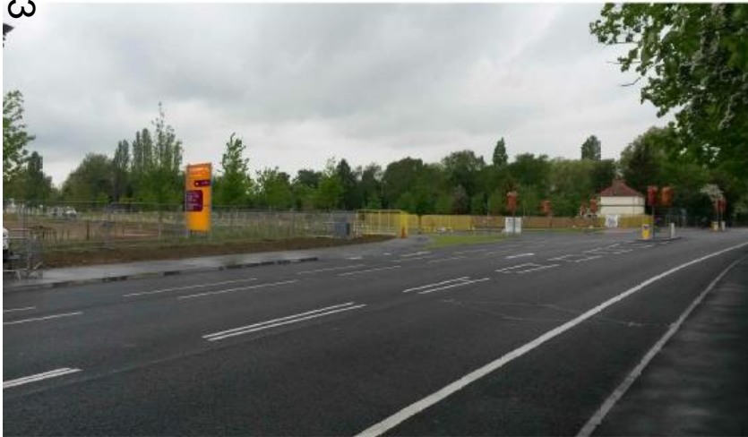
IM VISUAL ST2 - HUNTINGDON ROAD NORTH WEST
